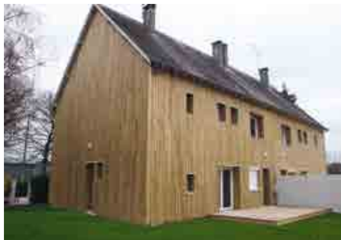
Avant/après d'un petit collectif à Marmagne (18) rénové et isolé par une seule et même opération grâce à la pose du K'ITE System d'Hylor, revêtu ici d'un bardage en Pin maritime autoclave classe 3 vert.
